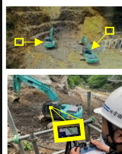
遠隔施工技術
