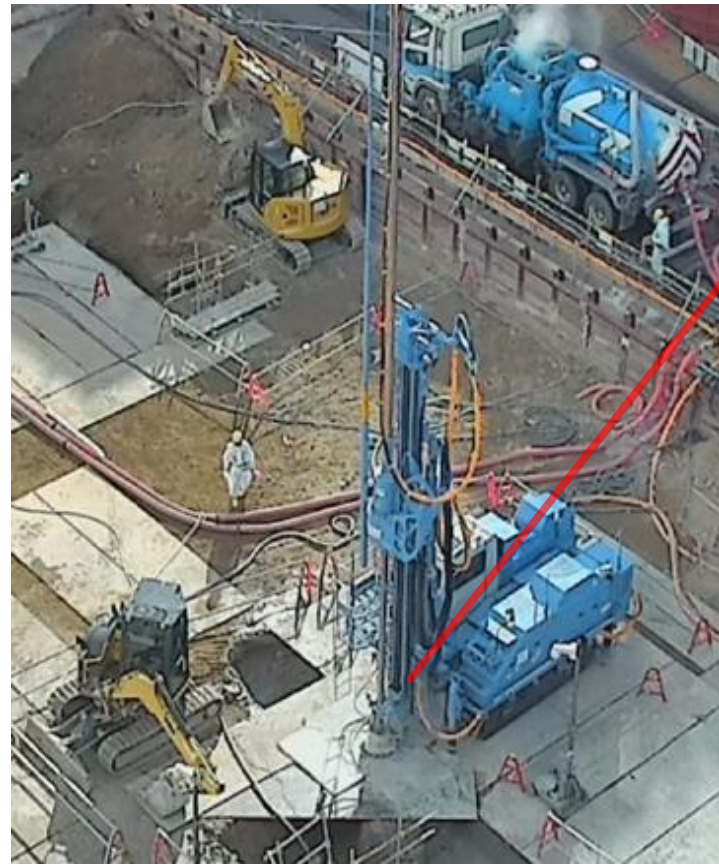
杭施工の様子
