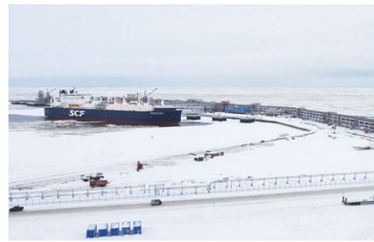
建設現場への輸送
