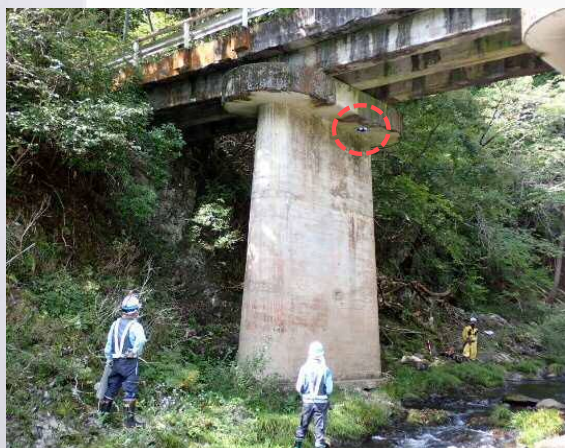
ドローンによる橋梁点検の実施状況
