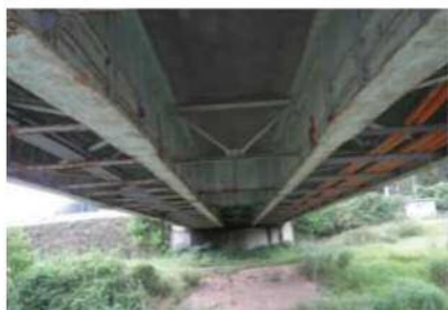
部材の腐食
