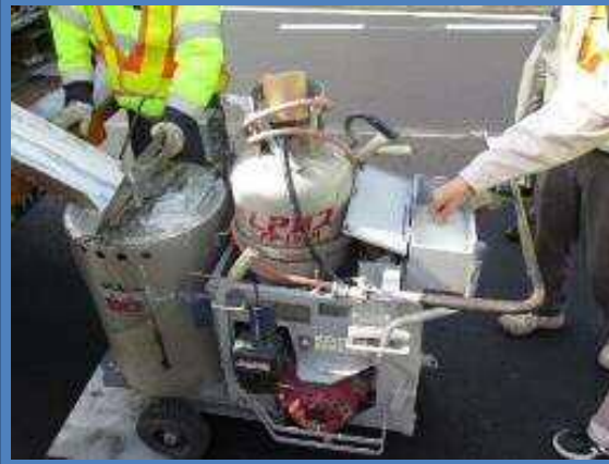
現地での試験施工 山陽ロード工業(株)
