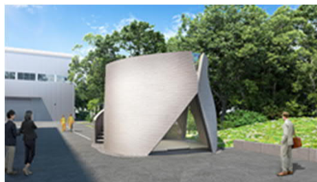
技研での3Dプリンターによる建屋建設
