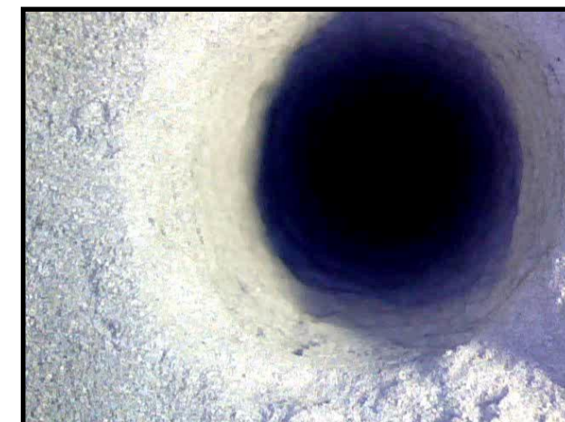
掘削孔内部の様子
