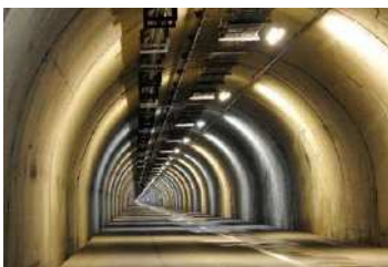
トンネル避難坑
