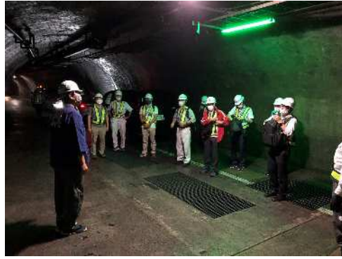
トンネル非難坑に進入
