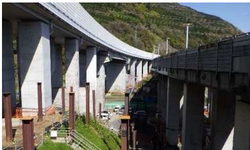
現場状況（高速道路橋梁）
