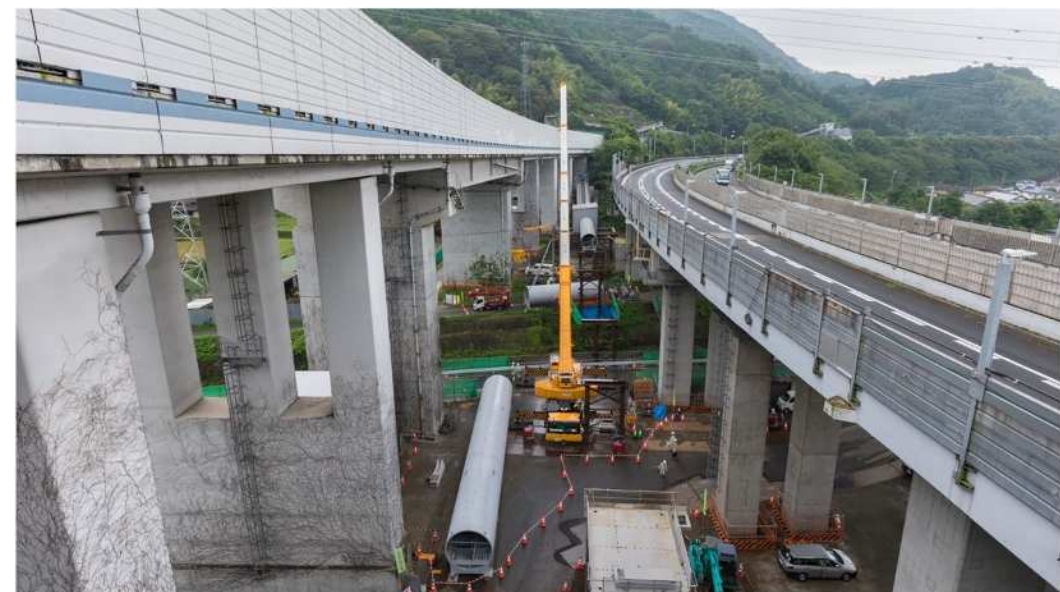
実際の施工状況
